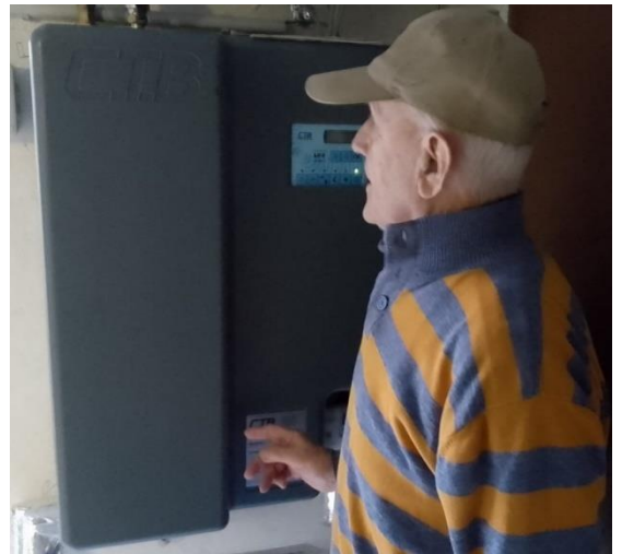
Günther Szedenik vor der Fernwärme-Übergabestation © P.Fellinger
